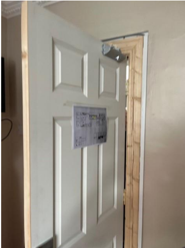
Fire Escape on door
